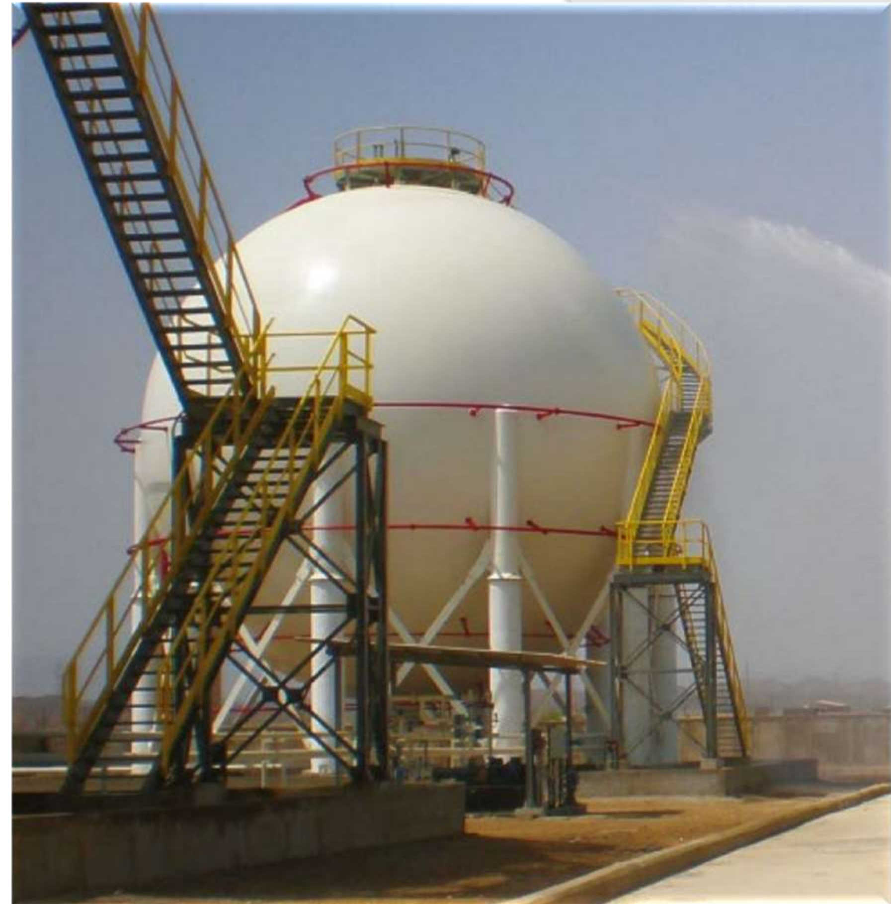
Test d'un moniteur d'eau sur un réservoir de GPL sphérique
