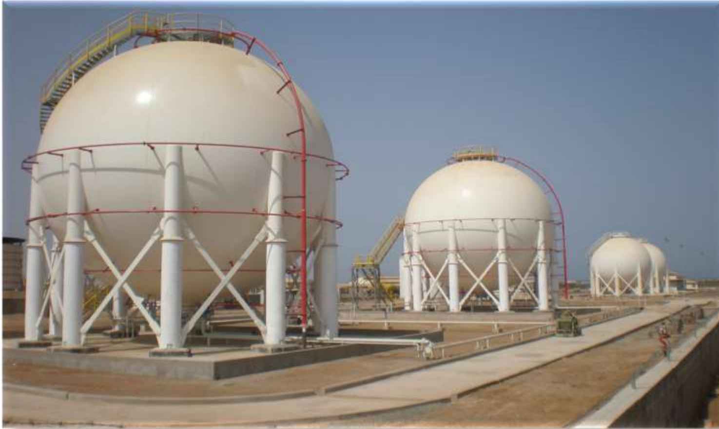
Stockage primaire de GPL – Réservoir sphérique – Massawa - Eritrea
