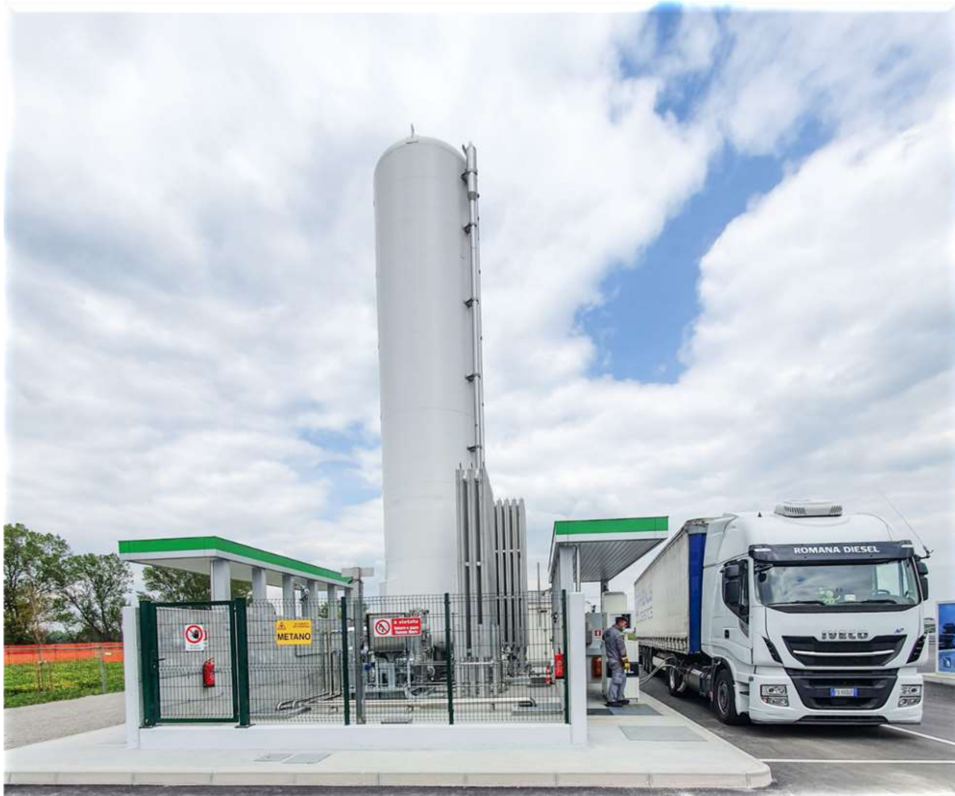
Station de ravitaillement en GNL – Fidenza - Italy
